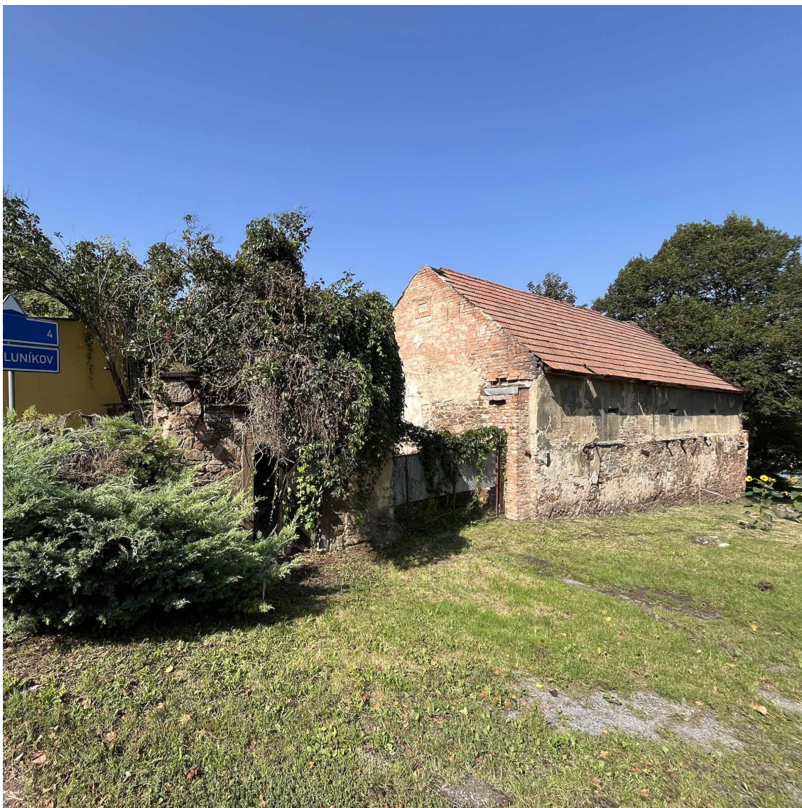
objekt stodoly s hlavním vstupem do areálu
